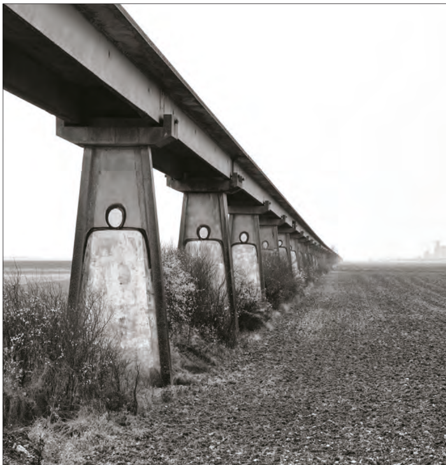
Jean-Marc Yersin - Photographie - Saran-Ruan Viaduc, Pilier 897
